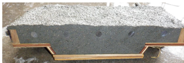
エアショットワンの鉄筋背面への充填状況
