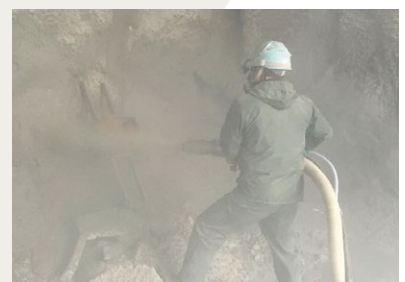
粉塵対策を実施していない乾式吹付工法
