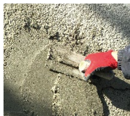
左官工法による施工状況
