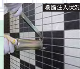
樹脂注入状況
