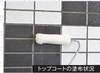
トップコートの塗布状況
