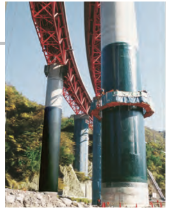
橋脚への施工例
