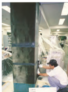
独立柱への施工例
