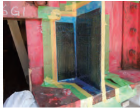
トラス・鋼桁への施工例
