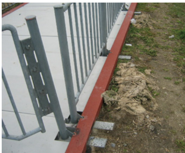
切欠き部の加工例
