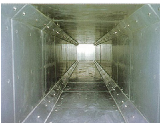
■ 暗渠（BOXカルバート）
