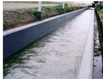
[JAGREE「農業水利施設補修工事品質管理士 講習会テキスト」開水路編、有機系被覆工法品質規格適合]
