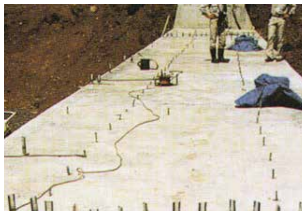
砂防ダムひび割れ補修
