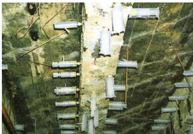
梁ひび割れ補修
