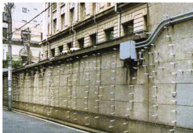
外壁ひび割れ補修
