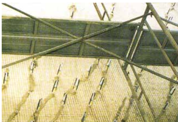
外壁タイルひび割れ補修
