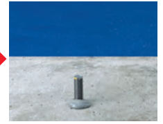
5.硬化養生 硬化時間内はボルトに触れないでください。
