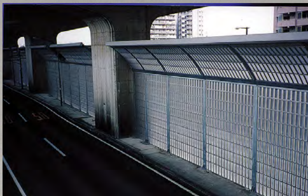
防音壁設置工事
