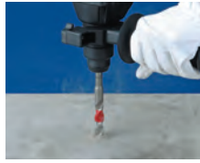
1.母材穿孔 ボルト固定位置にドリルで穴あけをします。
