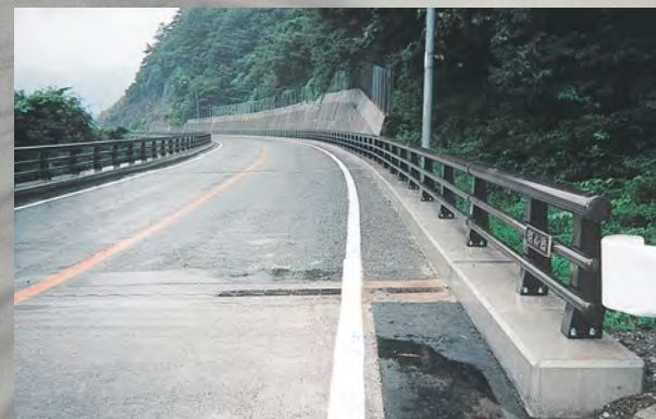
防護柵設置工事
