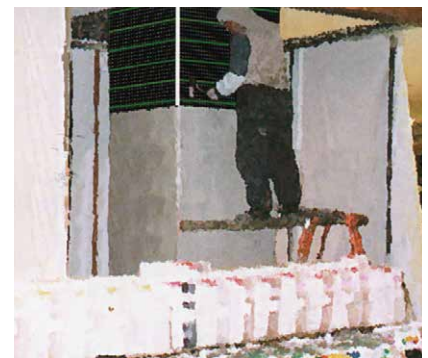
〈柱居〉(居ながら施工)
