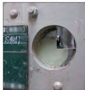
ウルトラパッチ貼付後
