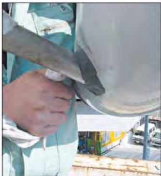
欠損部フィックスオールパテ充填
