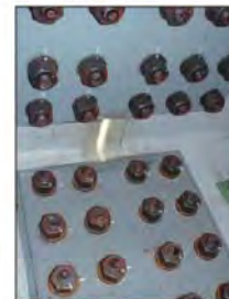
ウルトラパッチ貼付後
