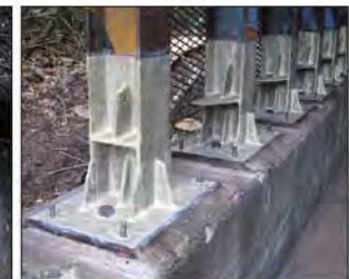
ウルトラパッチ硬化完了
