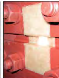
ウルトラパッチ貼付後
