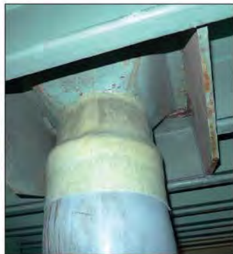
ウルトラパッチ貼付後
