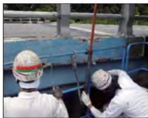
プライマー塗布
