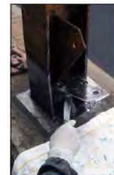
プライマー処理/不陸調整
