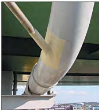
ウルトラパッチ貼付後
