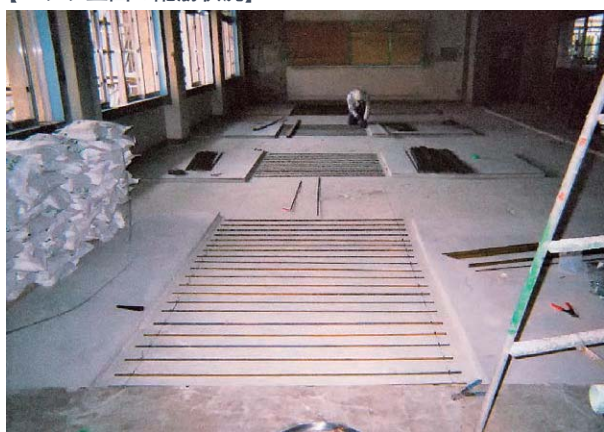
【スラブ上面の配筋状況】
