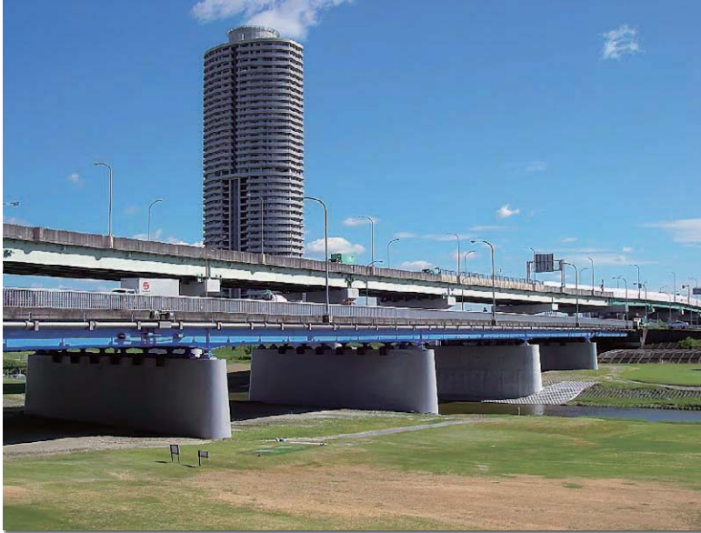
【河積阻害率の制約下での施工例】
