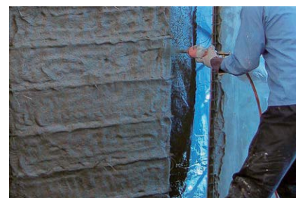
吹付け作業 タイプⅡ
