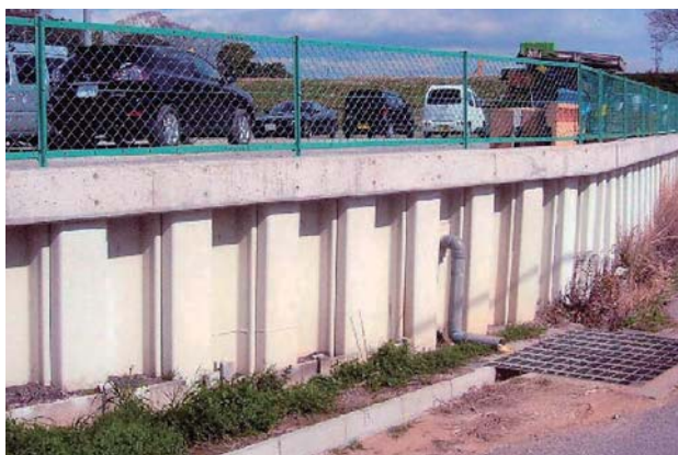
【鋼矢板の防錆】
