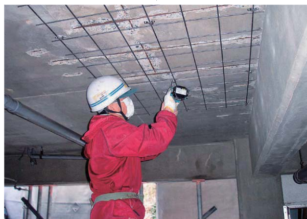
スラブ下面への補強筋配置
