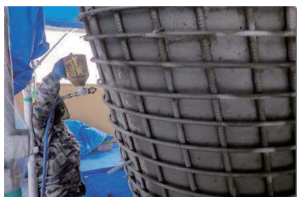
吹付け作業 タイプⅠ
