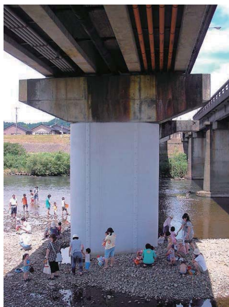
【鋼板巻立ての防錆塗装】
