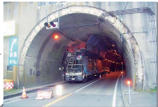
施工中(足場状況)
