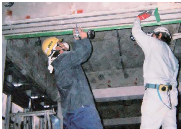
【梁下面の配筋状況】
