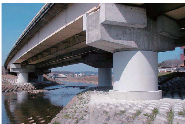
【鋼板巻立ての防錆塗装】
